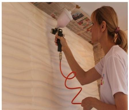
**Важно использовать освещение стены, которое планируется в интерьере помещения. Если есть ошибки монтажа и затирки швов, то они сразу будут заметны под источником света.**
