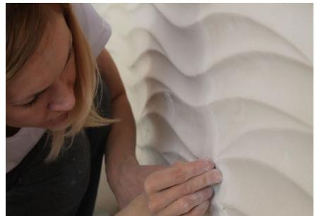
8. Если оставшийся участок стены не совпадает с размером панели, отпилить нужный размер панели ножковкой с мелким зубом. При необходимости кромку сгладить наждачной бумагой. Панели готовы к покраске.
