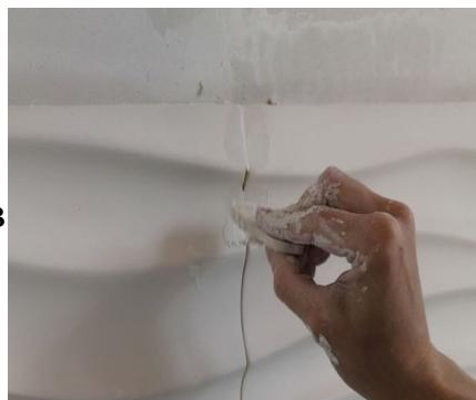
5. Аналогичным образом продолжить монтаж панелей по горизонтали и вертикали, совмещая рисунок. Для того, чтобы получить эффект цельной стены, необходимо выдерживать минимальное расстояние между панелями.
