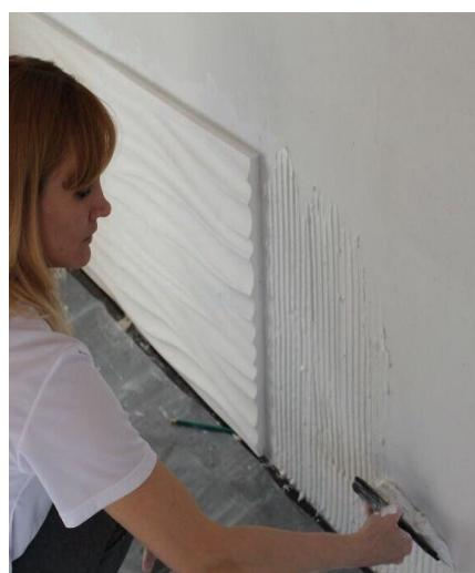
4. Клей(например «Knauf PerlFix») нанести на стену, приставить панель к стене, выравнивая по начертенным линиям.
